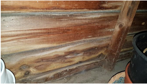
Förrådsvägg mot grannen
