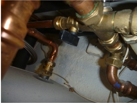
Påfylling för värmesystemet
